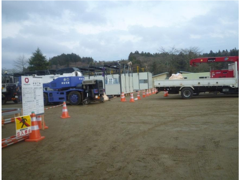
写真6: 米崎小学校 校庭 仮設住宅建設中
