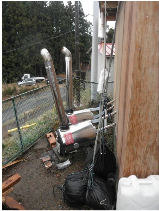
写真7:薪で風呂を焚ける装置があった。外からの様子
